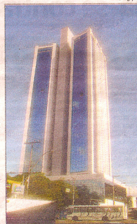
Prédio fica próximo ao Teatro
